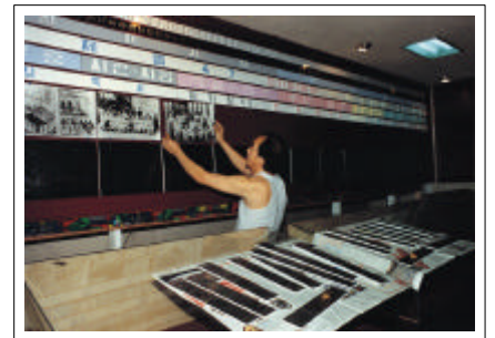
연혁벽판 시공 장면
